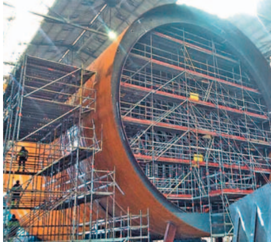
Galictio ha suministrado andamios para obras de eólica marina.
