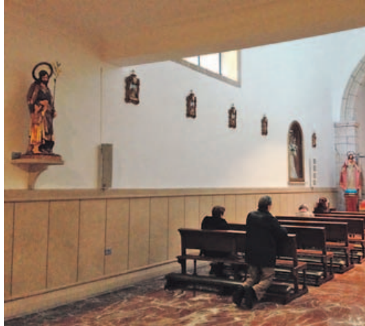
Convento de Santa Bárbara, A Coruña, donde se trató un problema de humedad.
